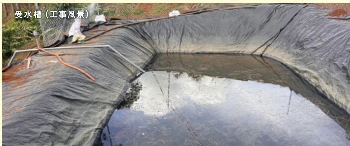
スプリンクラーの 設置
